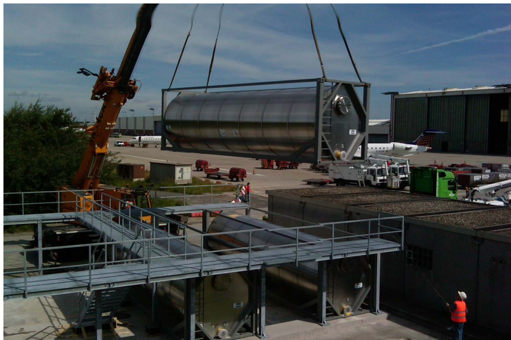
Instalación de los contenedores cisterna
